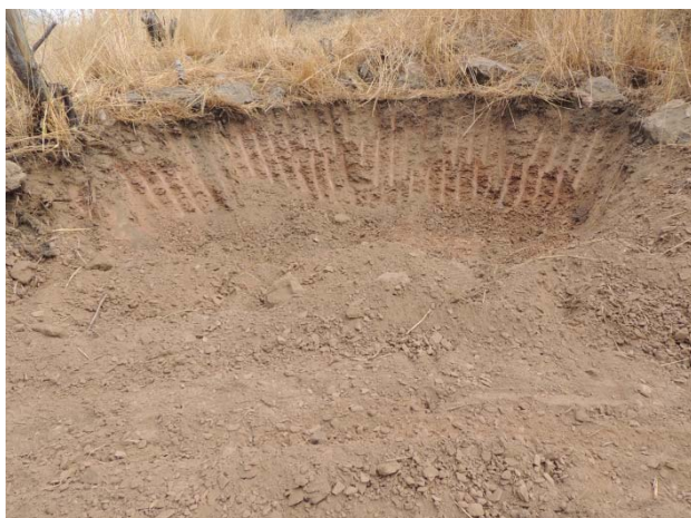
Foto 2.7 – Ombreira direita: Talus sobreposto ao solo de alteração de ardósia - Est.29+00 (E=302.204; N=9.582.275).
